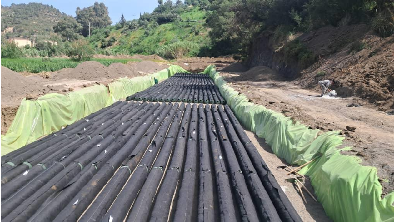
Travaux de mise en œuvre de la station d'épuration
