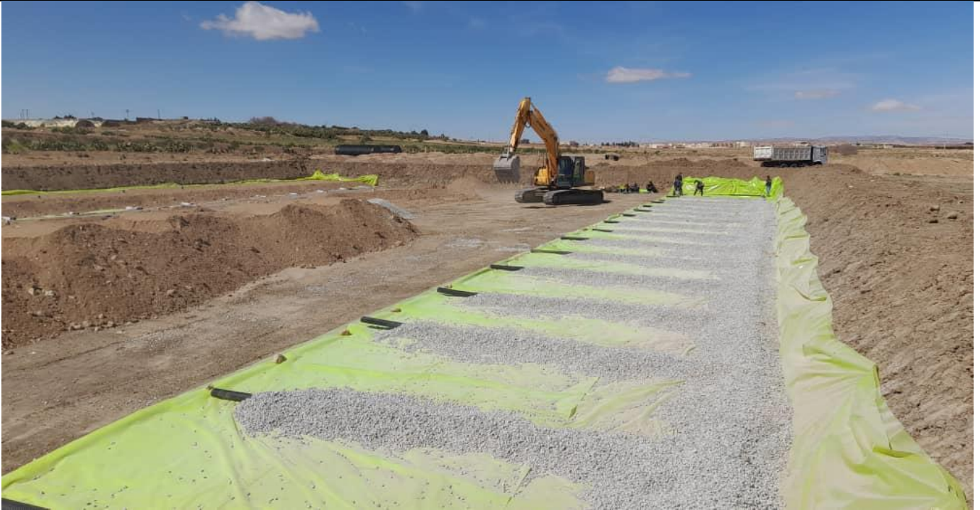
Travaux de mise en œuvre de la station d'épuration
