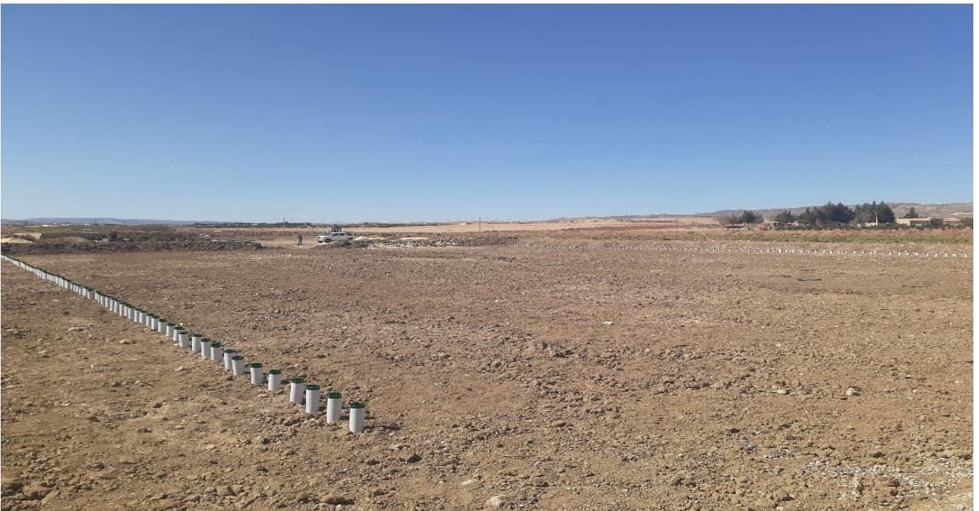
Station d'épuration finalisée
