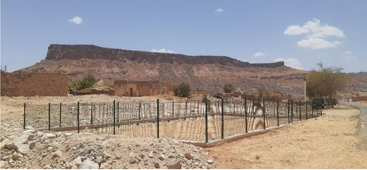
Travaux de mise en œuvre de la station d'épuration de Hay TIN ABRIK
