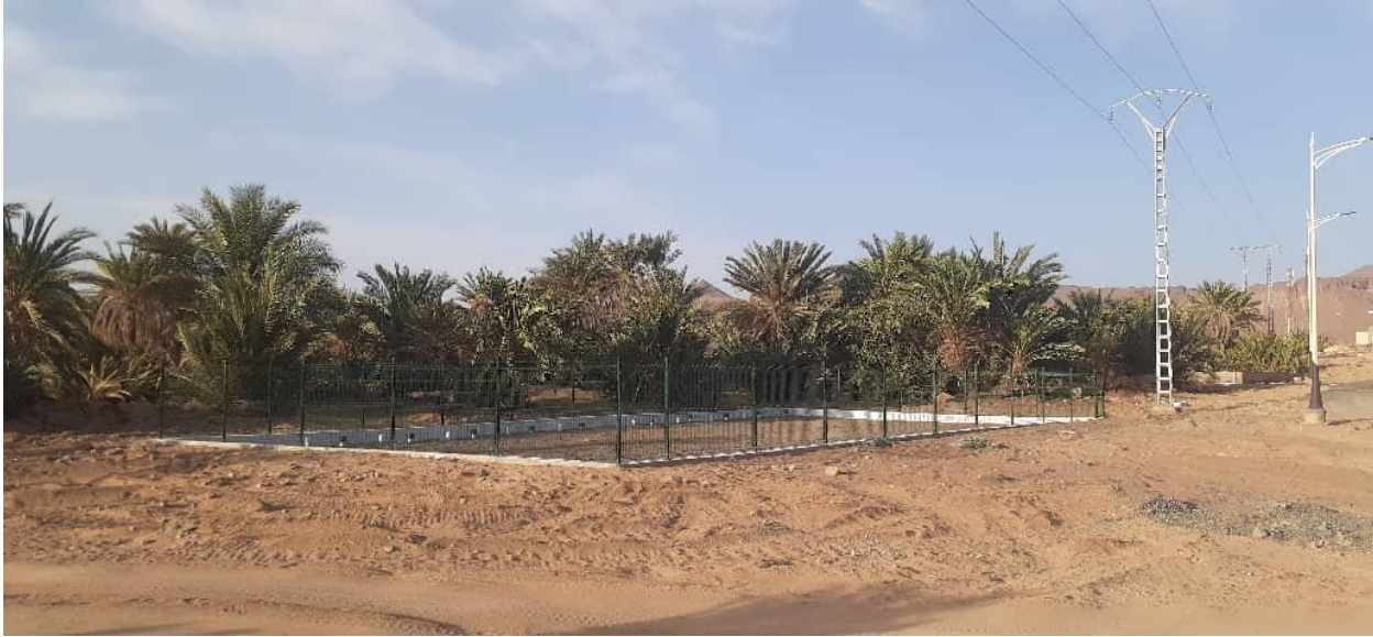
Travaux de mise en œuvre de la station d'épuration de Hay DAK AZIR.
